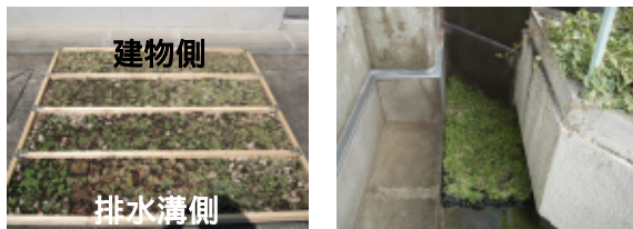
図-2 施工直後の実施場所
