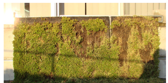
図 8 施工後 6 ヶ月の壁面の様子
