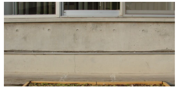
図 5 施工前の壁面の様子
