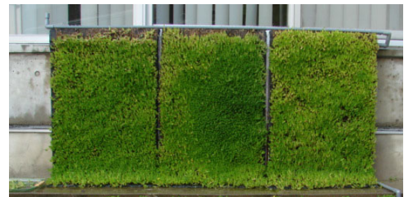
図 6 施工後の壁面の様子
