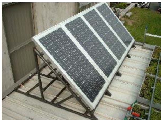
図-1 ソーラーパネルの設置方法
