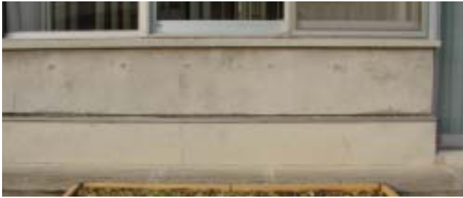
図4 施工前の壁面の様子
