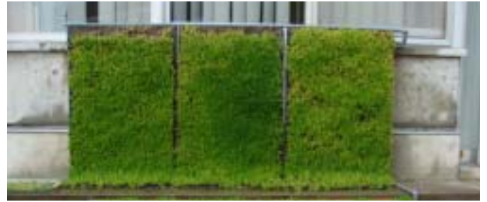
図5 施工後の壁面の様子
